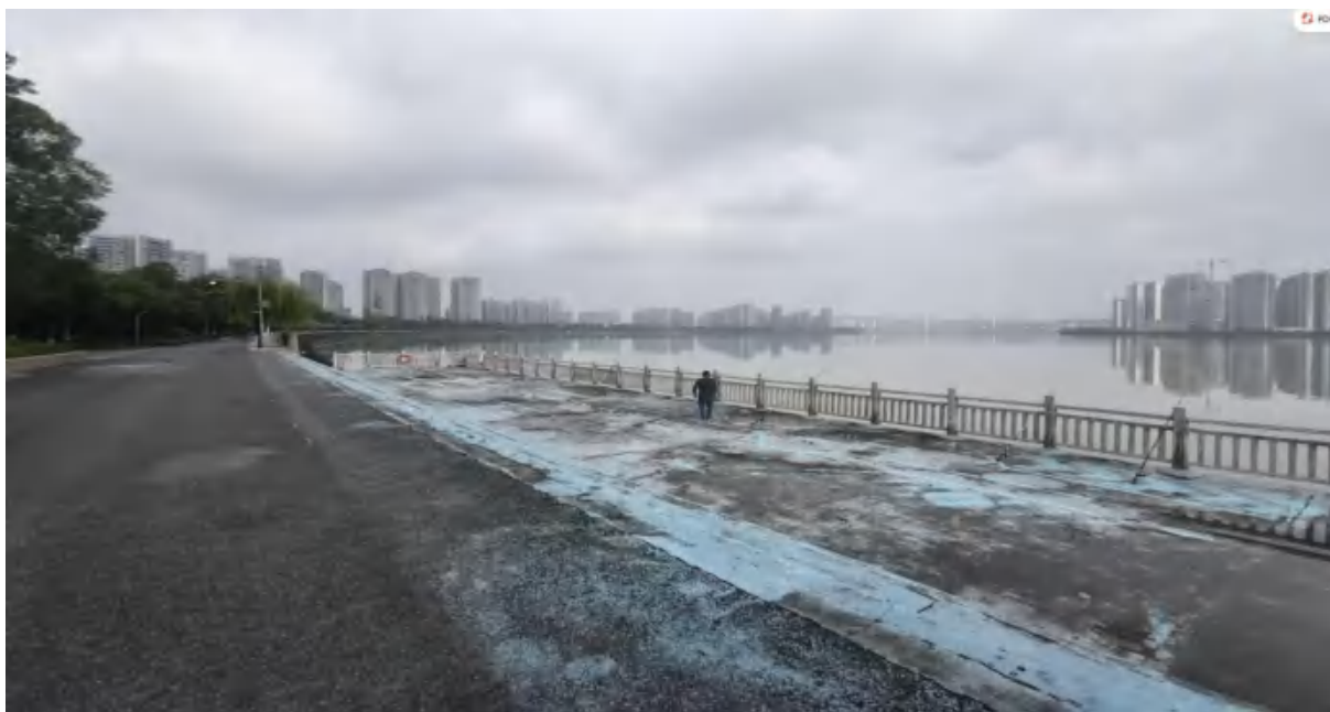
图 2.1-3 涪滨路段亲水平台现状
